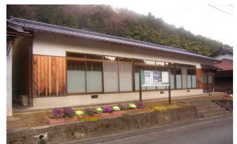
③保全対象 餅耕地公民館(避難所)
