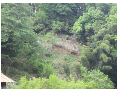
①斜面状況(崩壊跡)
