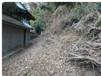
③保全対象とがけの状況
