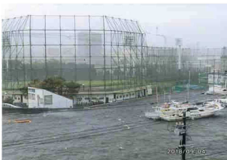
平成30年台風21号高潮状況
