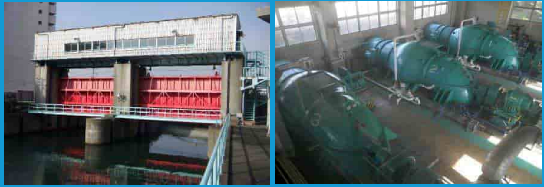
現在の新川水門、新川排水機場
