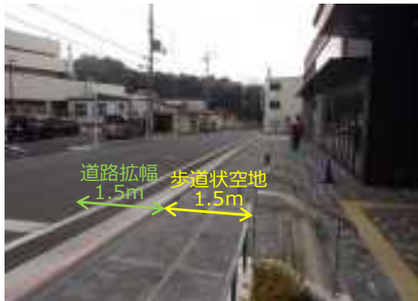
【道路拡幅状況（公共施設整備）】
