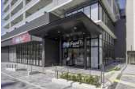
【駅に面した商業施設エントランス】
