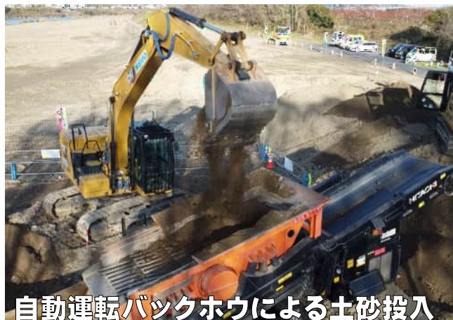
遠隔操作バックホウによる掘削積込
