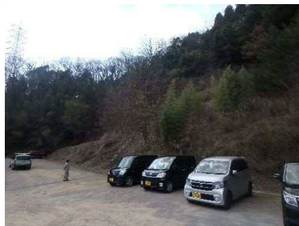
③斜面状況
