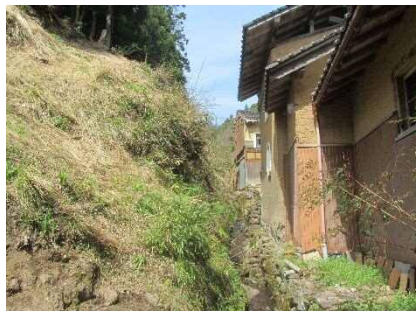
③ 斜面状況(人家裏)
