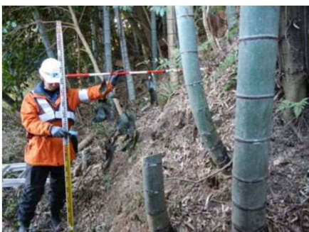
②斜面状況(人家裏)
