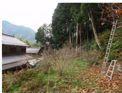
③保全対象とがけの状況
