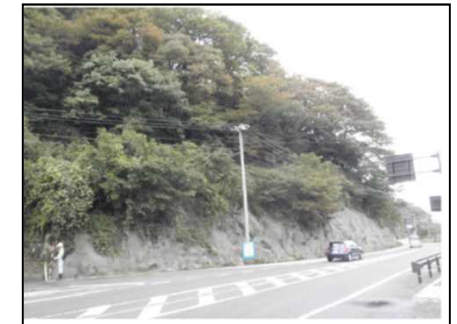
写真2 道路防災総点検危険箇所
