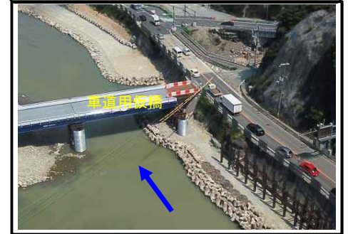
②事業中区間(西宝橋車道用仮橋)
