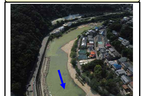
④残事業区間(西宝橋上流付近)
