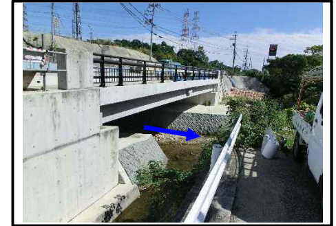
②完成区間(第一小浜橋)
