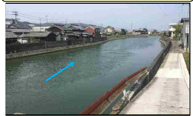
② 新山王橋から下流(山王橋側)
