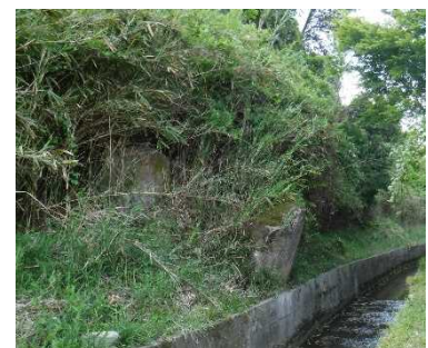
④斜面露岩状況
