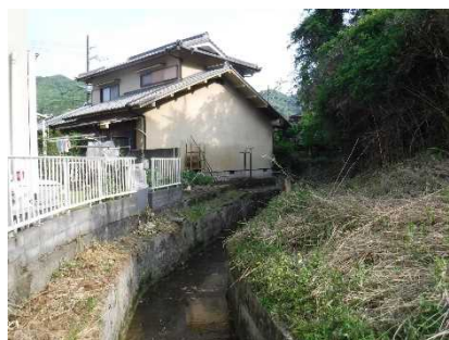
③保全対象とがけの状況
