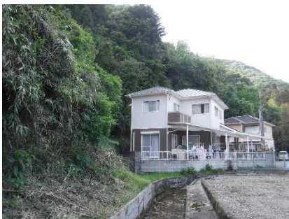
②斜面の状況
