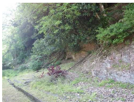
③斜面状況
