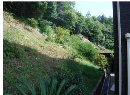
③保全対象とがけの状況
