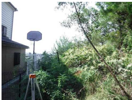
②保全対象とがけの状況
