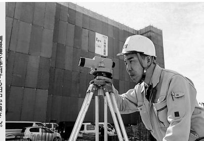
測量機を使用する田中宏典さん。図面でも示された建物の高さや位置取りを現場で測る。
