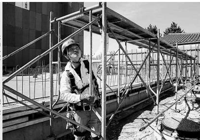
移動手段として多くの職人が利用するため、使いやすい足場を設置する筒井大樹さん。
