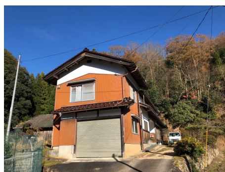
③ 保全対象(人家)
