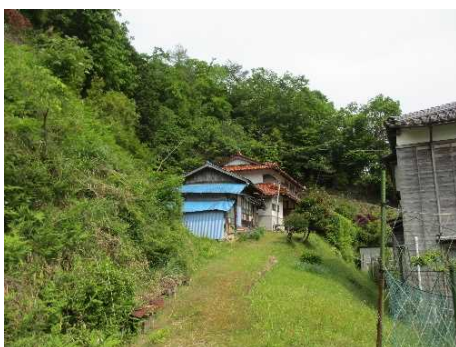
② 保全対象とがけの状況
