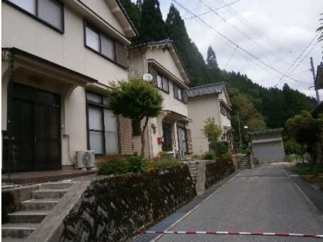
③ 保全対象(人家)
