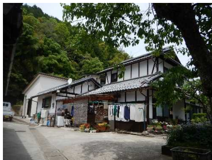
③保全対象(人家)
