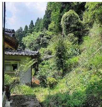
③保全対象とがけの状況
