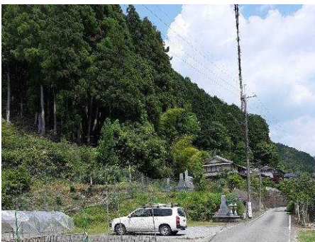
②斜面の状況
