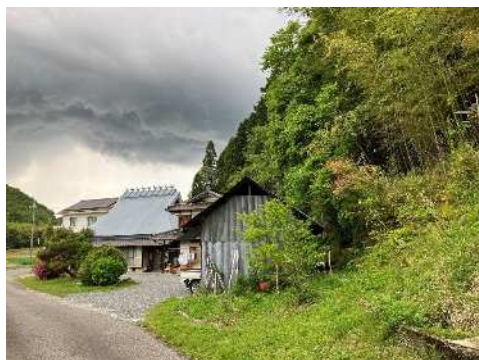
③保全対象とがけの状況
