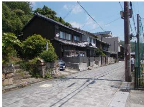
③ 保全対象(人家)
