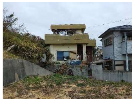
③ 保全対象(人家)
