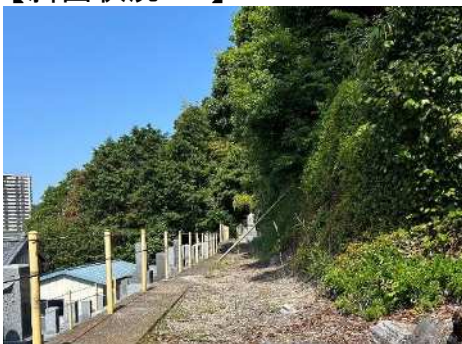
② 保全対象とがけの状況
