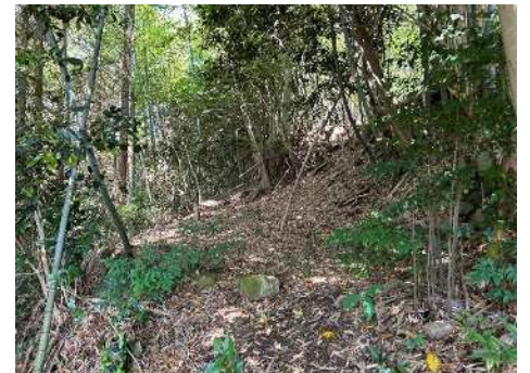
④ 斜面状況
