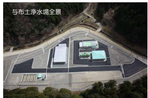
与布土浄水場 (朝来市整備)
