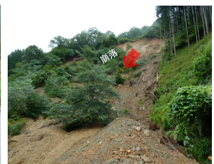
貯水池上流左岸法面崩壊状況
