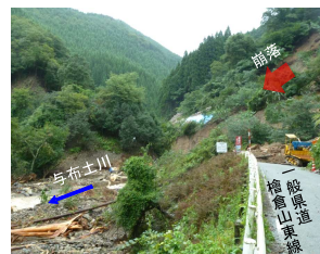
貯水池上流左岸法面崩壊状況
