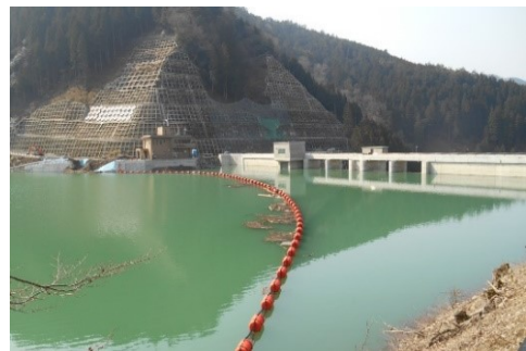
試験湛水の状況 (右岸より堤体を望む)
