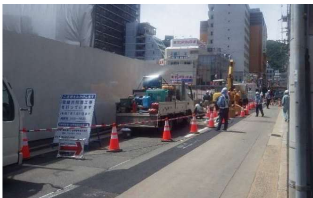
電線共同溝整備工事中(8月時点)
