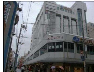
②施設の耐震性不足
