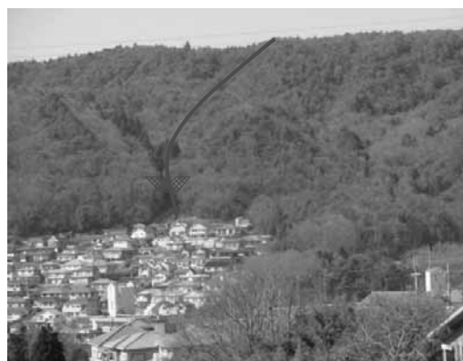
カツカ谷川右支溪 砂防事業(北区)
