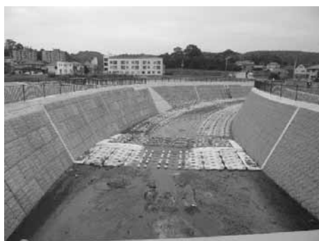
志筑川(放水路) 広域河川改修事業 (淡路市)
