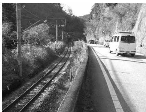
篠山山南線 道路事業(篠山市) 川代トンネル計画区間の現道状況
