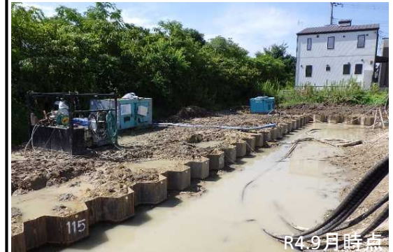
③矢板打設状況
