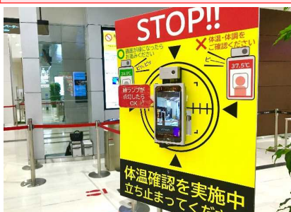
体温測定カメラの設置
