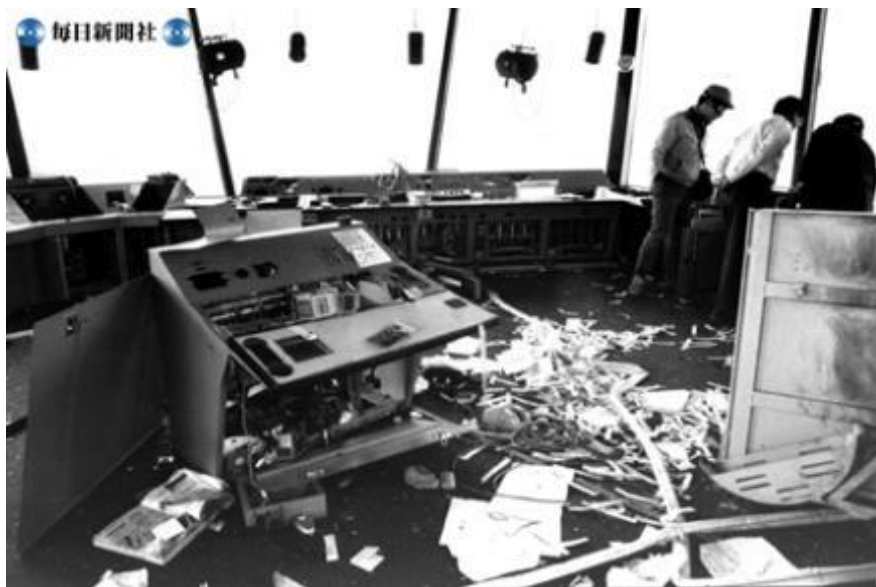
破壊された管制卓
