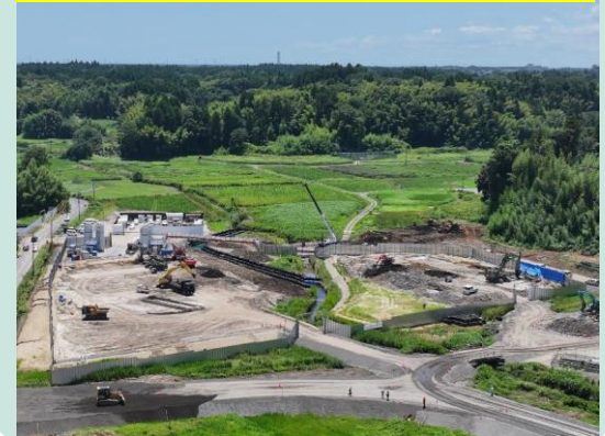
代替道路のトンネル整備
