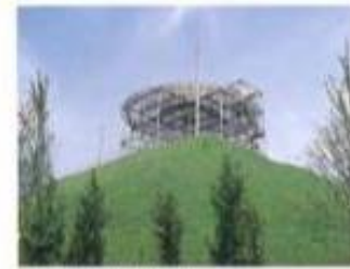
航空保安無線施設(VOR/DME) コウノホリ豊岡空港で離発着する航空機に、空港の方位や空港までの距離を知らせます。
