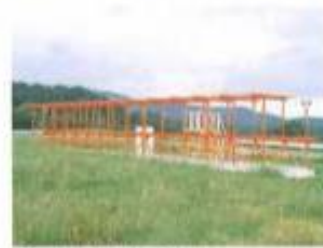
航空保安無線施設(LLZ/T-DME) 誘導電波により、航空機の着陸を援助します。
