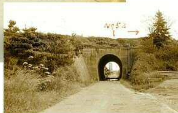
昭和26年頃の荒牧トンネル 11
