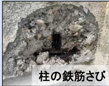
柱の鉄筋さび
