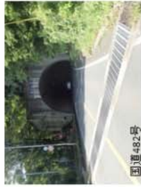
国道482号 (道路横断グレーチングの状況)
