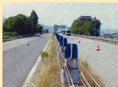
防草シート敷設前
