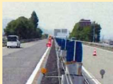
防草シート敷設後
