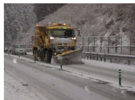
除雪作業①
