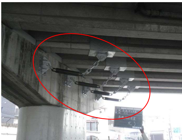
【落橋防止構造の設置】
