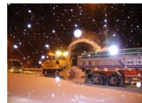
除雪作業②
