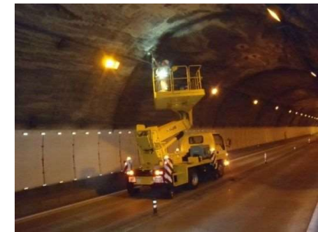
トンネル点検
