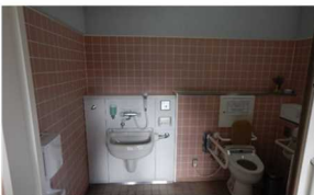
トイレ施設 再利用水を用いているため災害時も利用可能
