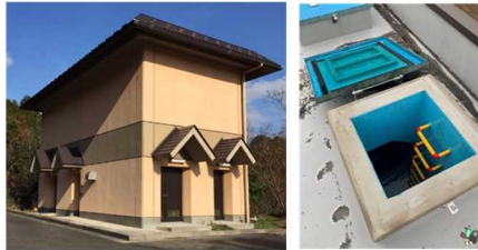
災害用貯水タンク 道の駅施設及び給水用50t×2基=100t
