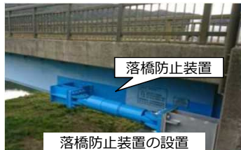
落橋防止装置の設置
