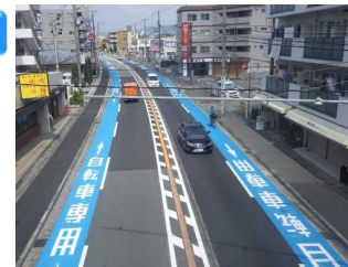
県道姥ヶ茶屋伊丹線(伊丹市)
