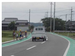
路肩カラー舗装
