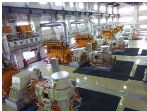
ポンプ設置状況(口径2,300mm×6台)
