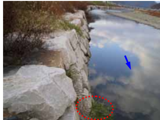
施工後1年（近景）
