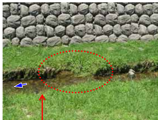
施工後7年6ヵ月
