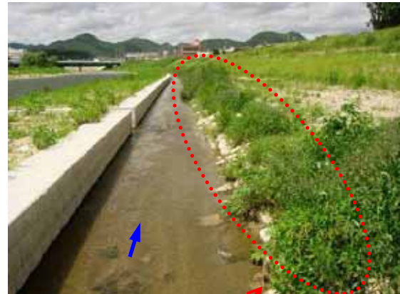
施工後 1 年 3 ヶ月（近景）
