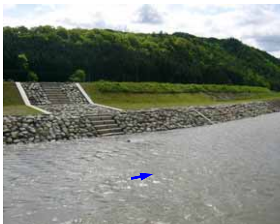
施工直後（左岸）
