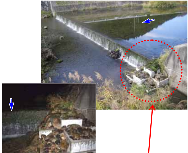
平成 22 年度施工
