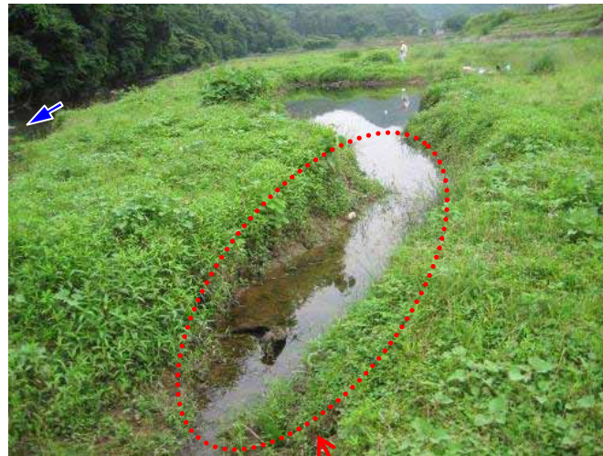
施工後3年4ヵ月
