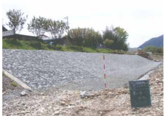
施工直後（カゴマット工）
