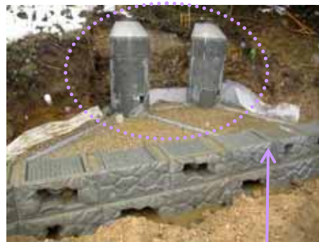
観察用マンホールの構造（オオサンショウウオ用ブロックから接続）
