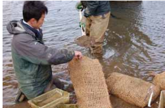
土嚢袋に現地土壌を充填し、土嚢袋内の隙間を埋める
