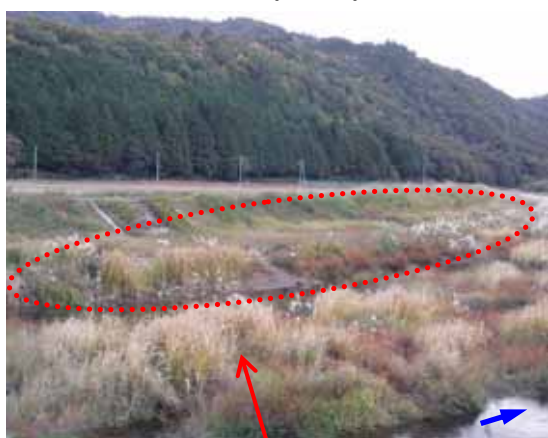
施工後4年8ヵ月（左岸）
