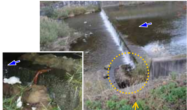
平成 19 年度施工
