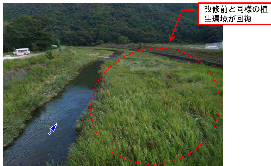
施工後3年6ヵ月
