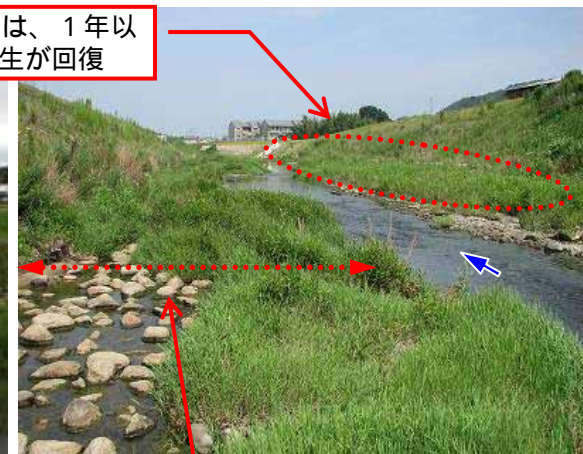
施工後 10 ヶ月 (近景)
