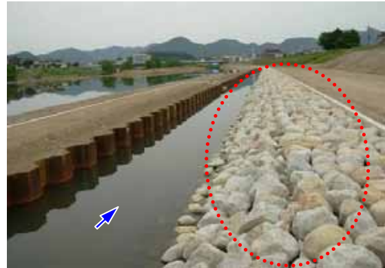
施工直後（近景）
