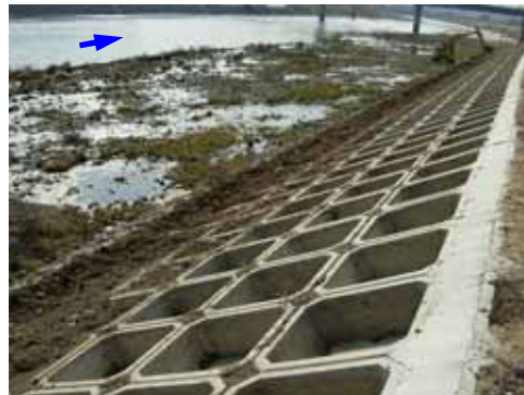
施工中（緑化ブロック工）
