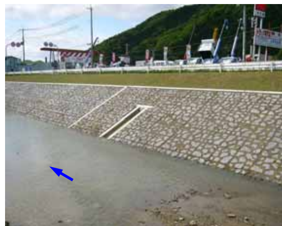
施工直後（右岸）
