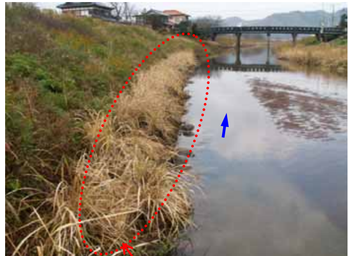
施工後2年9ヵ月
