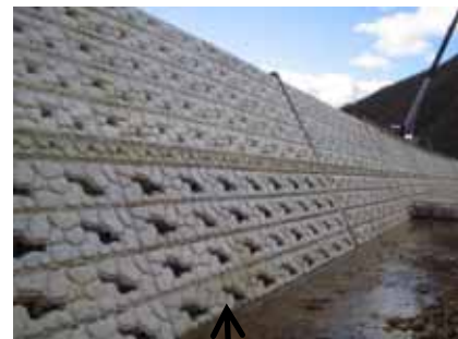
護岸に空隙を創出ことで、魚類等の生息や隠れ場となる
