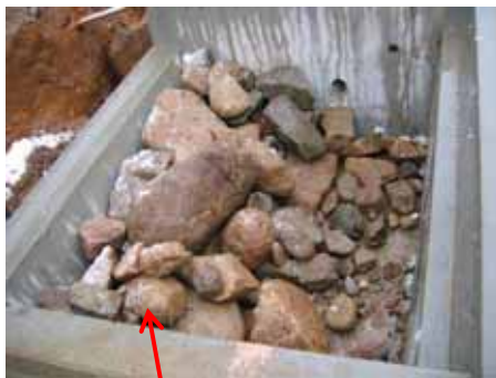
オオサンショウウオ用ブロックの内部には、自然石やパイプを用いて巣穴環境を創出している
