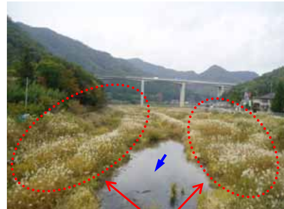
施工後2年6ヵ月
