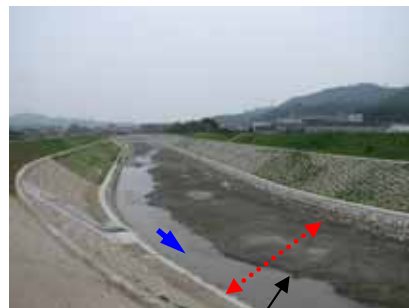
施工前の横断形状を参考に断面形状を決定
