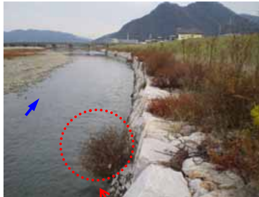
施工後1年（遠景）
