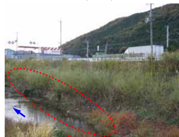
施工後4年8ヵ月（右岸）
