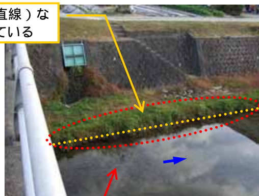
施工後 1 年 8 ヶ月（近景）
