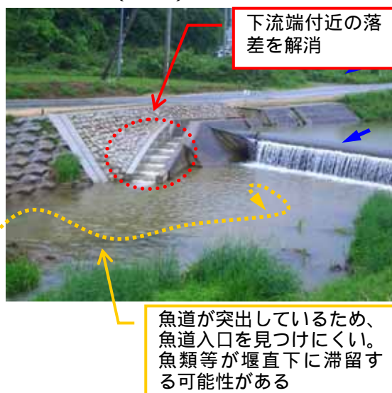
施工後4年（遠景）
