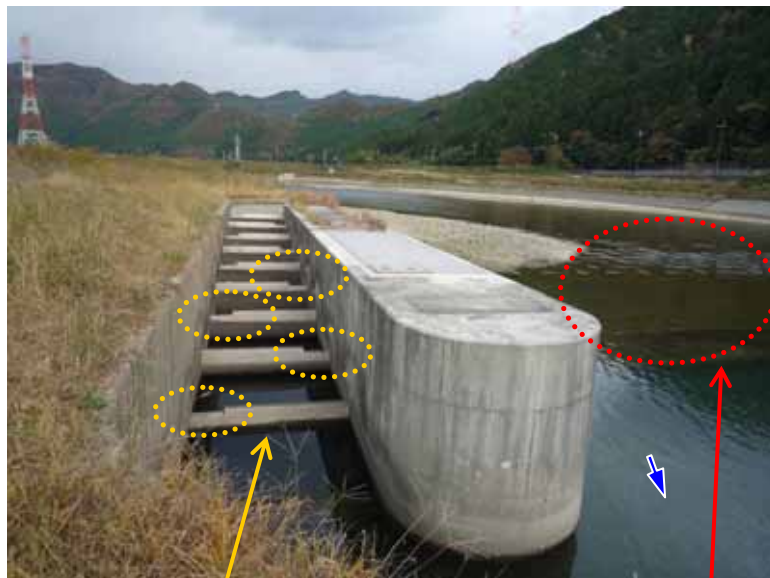
施工後3年6ヵ月
