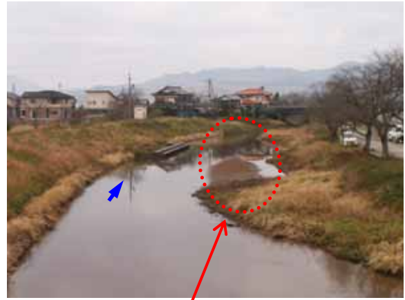
施工後2年9ヵ月
