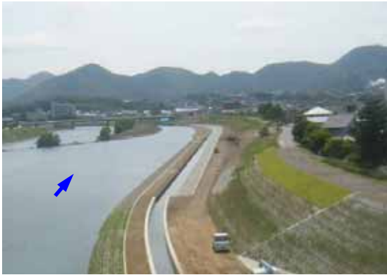
施工直後（遠景）
