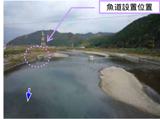
施工後3年6ヵ月
