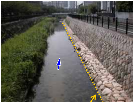
施工後1年1ヵ月（遠景）
