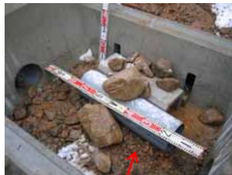
オオサンショウウオ用ブロックの内部には、自然石やパイプを用いて巣穴環境を創出している
