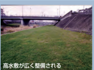
高水敷が広く整備される
