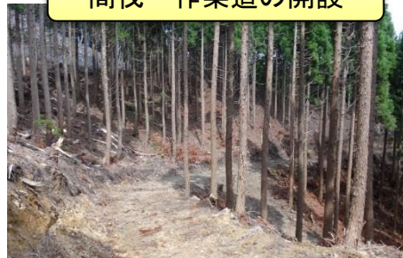
間伐・作業道の開設
