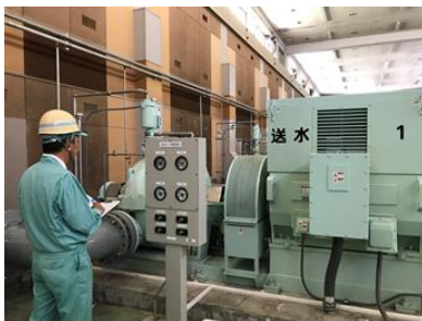
施設点検状況 (神戸市)
