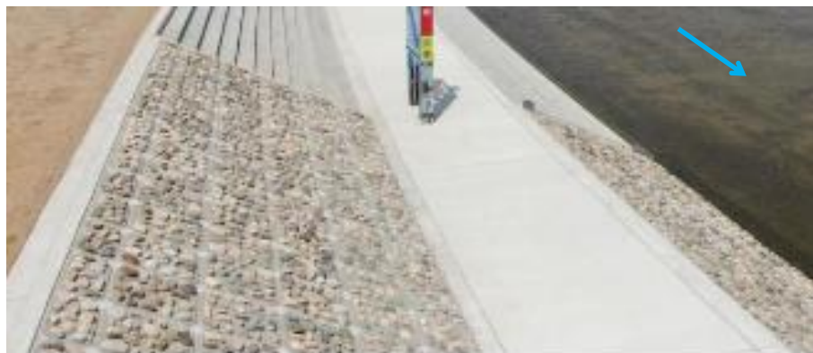
仁川合流点に堆積していた自然石を利用し、護岸を整備
