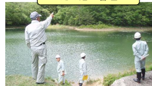
ため池定期点検の実施
