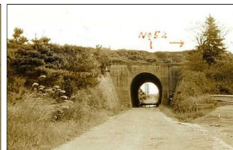
写真-1.2 荒巻トンネル (昭和26年頃)
