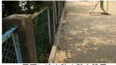
周囲に流出防止壁を設置
