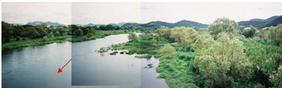
写真 2.2.2 河道内樹木の状況(市川 阿保橋上流)
