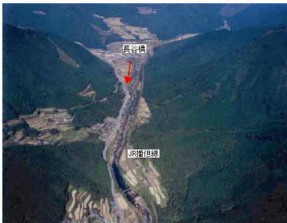
写真 1.1.1 上流（神河町 長谷橋付近）
