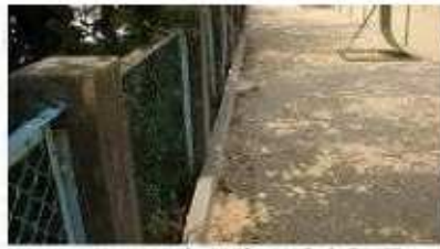
周囲に流出防止壁を設置
