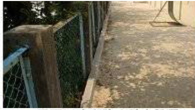
周囲に流出防止壁を設置
