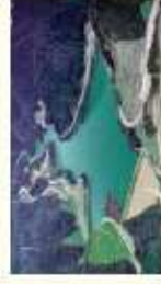
金出地ダム(上郡町)建設中
