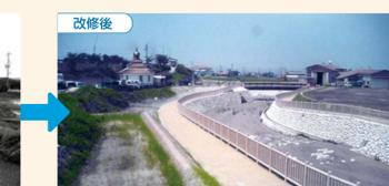
改修工事では、環境・景観への配慮などの点から「アンカー付自然石積」を取り入れました。また、親水性を高めるために、階段護岸を2箇所に設置し、学習の場としても活用できるようにしています。
