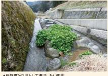
普通河山田川では、当初急勾配の河床に護床ブロックを設置する計画でしたが、国土技術政策総合研究所の「多自然川づくりアドバイザー」から助言を受け、現地発生の自然石を用いた分散型護岸工に見直しを行いました。
