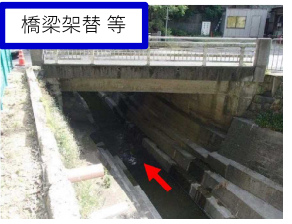
橋梁架替等 妙法寺川(中流域工区)
