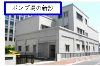
ポンプ場の新設 中突堤ポンプ場(中央区)
