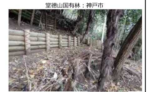
森林整備と土砂流出対策 木柵工設置 (林野庁 兵庫森林管理署)
