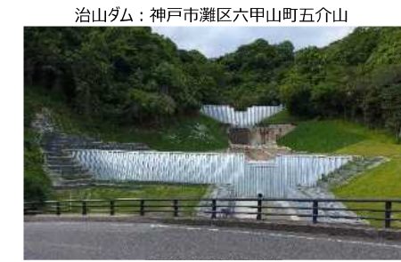
治山ダム：神戸市灘区六甲山町五介山 治山ダムの設置 (兵庫県 六甲治山事務所)
