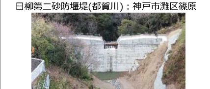
日柳第二砂防堰堤(都賀川)：神戸市灘区篠原 砂防堰堤の設置 (国土交通省 六甲砂防事務所)
