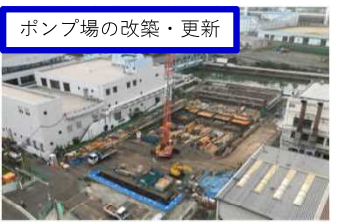
ポンプ場の改築・更新 魚崎ポンプ場(東灘区)
