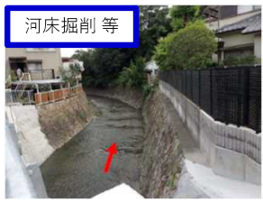
河床掘削等 妙法寺川(板宿工区)
